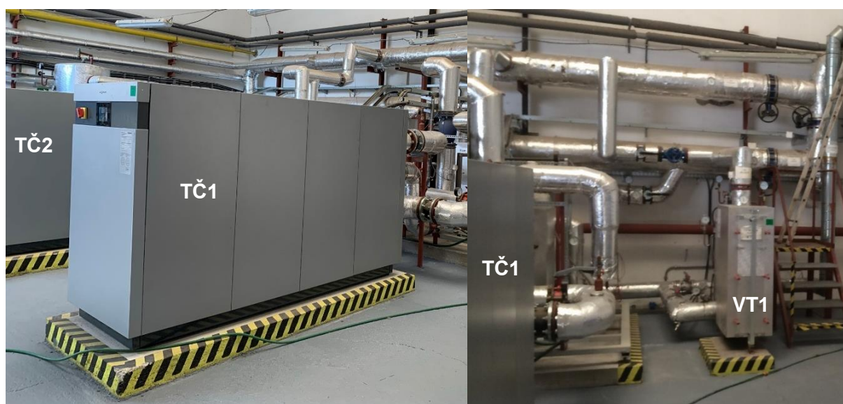
Obrázok 11: Technológia kotolňa K5 – tepelné čerpadlá
